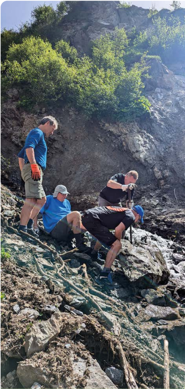
Nach einer Mure am Bachübergang des Aufstiegsweges zu unserer Hütte mussten bei der Wiederherstellung des Weges große Brocken bewegt werden. Mehr dazu ab Seite 10.
